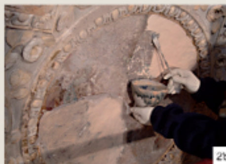
IMMAGINE 2a. Applicazione di bendaggio di sostegno e protezione su parti di pericolo di caduta.
