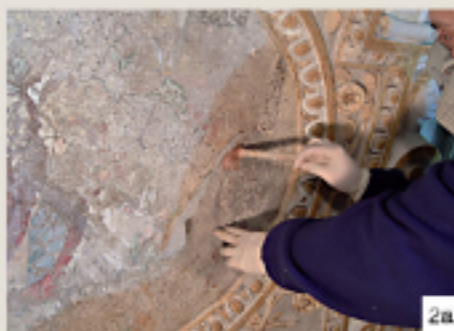
IMMAGINE 2a. Applicazione di bendaggio di sostegno e protezione su parti di pericolo di caduta.
