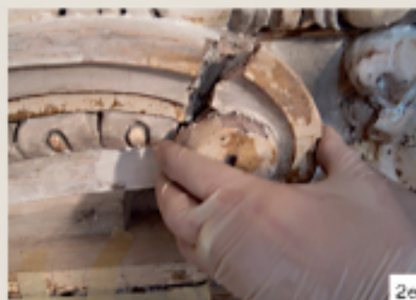
IMMAGINE 2f. Riadesione del frammento, fissaggio.
