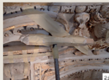
IMMAGINE 2f. Riadesione del frammento, fissaggio.
